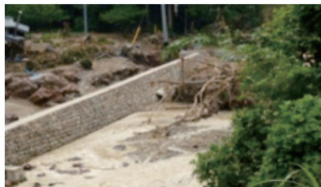
平成25年の島根県及び山口県の大雨の被災現場 (島根県津和野町提供)
