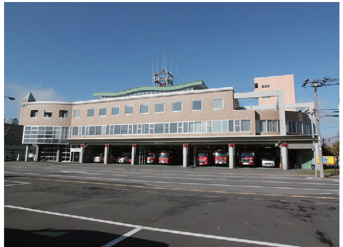
消防本部のある、美瑛消防署庁舎
