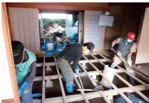
床下の泥だし (常総市社会福祉協議会地域支えあいセンター提供)
