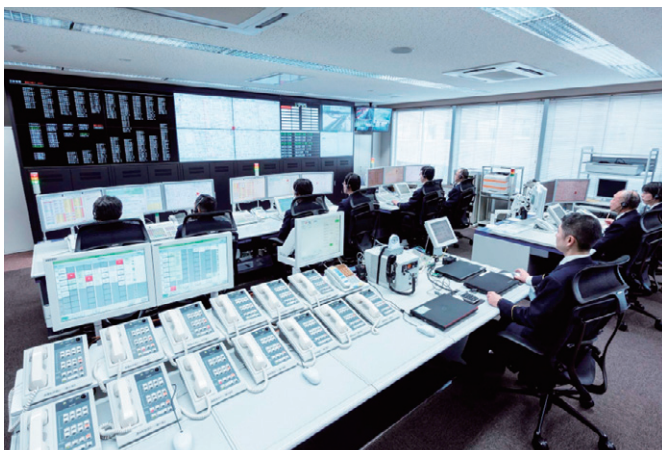
消防指令センター
