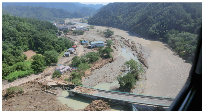
岩手県岩泉町乙茂地区の被災状況 (岩泉町提供)
