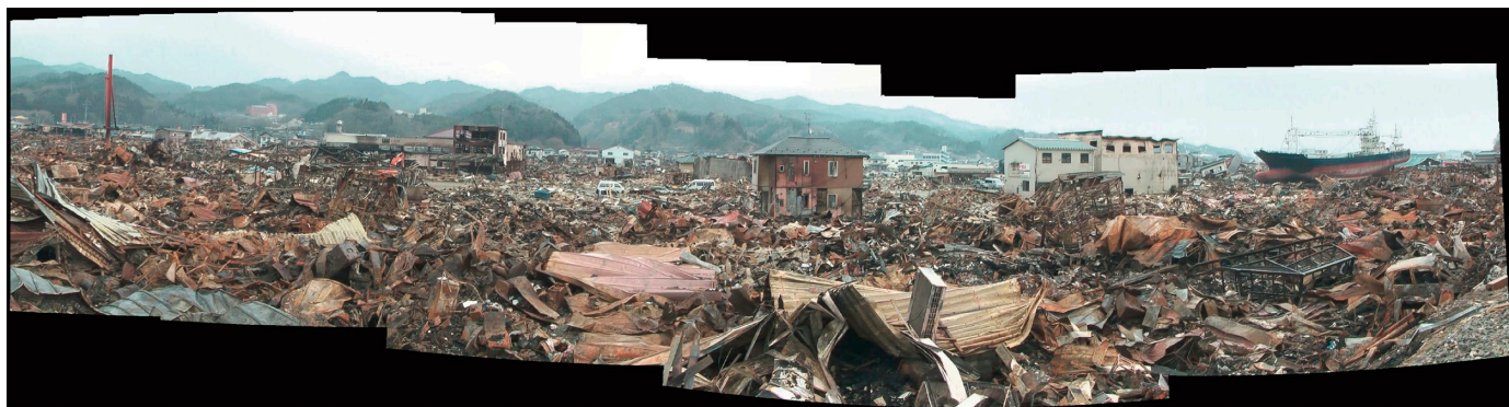
宮城県気仙沼市内の大船渡線線路付近から東側一帯を見た焼損等の状況（右奥が海）
