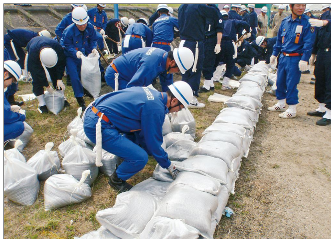
消防団員の台風・集中豪雨等の水防活動（土のう積み）
