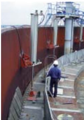
図3 タンク側板に設置されたシリンダー
