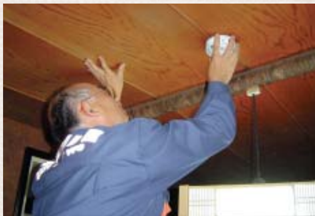
住宅用火災警報器を取付ける消防団員
