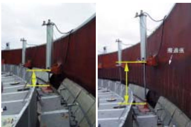
図4 最高揺動高さとなった浮き屋根(左)と最低揺動高さとなった浮き屋根(右)
