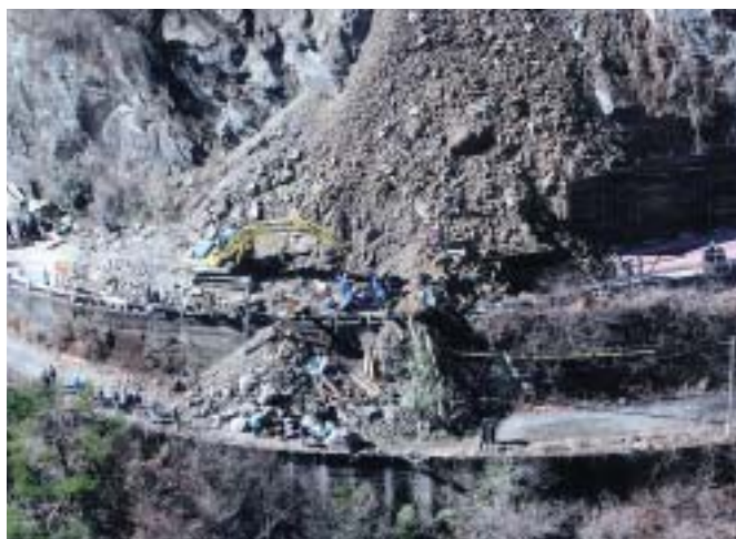
土砂崩れ現場
