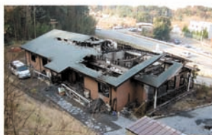
火災発生後の外観
