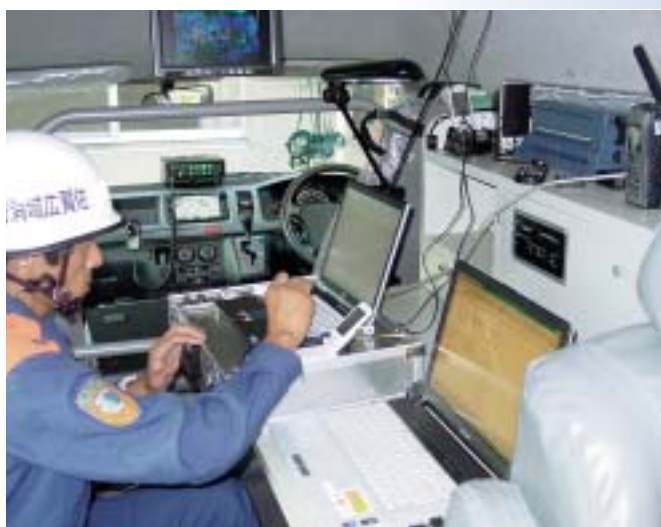
車内に装備する通信設備
