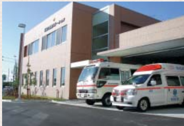
新潟市救急ステーション(救急ワークステーション)
