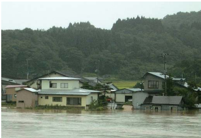
平成19年9月 河川の氾濫により浸水した家屋 (写真提供：秋田県)
