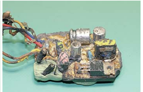
写真5 電源基板の状況(部品面)
