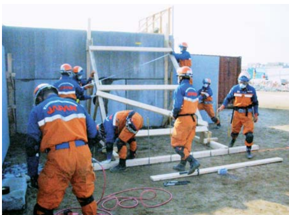
安定化技術(ショアリング)
