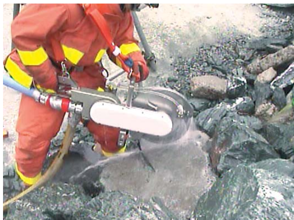
高圧水駆動によりコンクリート片を切断
