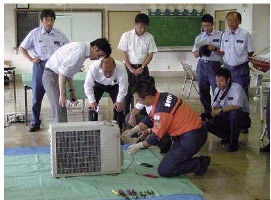
写真3 エアコン室外機を分解し調査している状況
