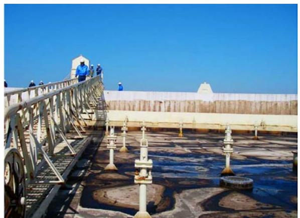
図3 スロッシングによるデッキ上への油の流出
