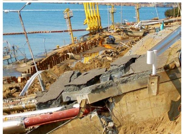
図6 太平洋側で発生した津波によるパース（上）と護岸（下）の被害
