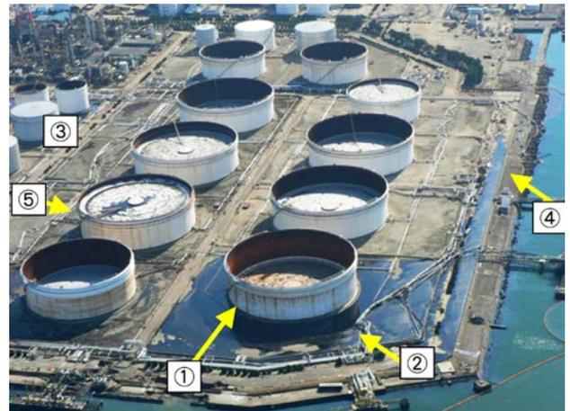
図2 ①津波はタンク底板から約3.5mまで到達、当該タンクは空であったが浮上や移動の現象は見られない。②、③多数の配管の折れ曲がり、危険物が漏えいした。④護岸、棧橋、防油堤の損傷が大きかった。⑤スロッシング波高は約1mで、浮き屋根上に油が流出した。
