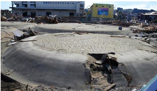
図5 津波によりタンク本体が流れてむき出しになったタンク基礎
