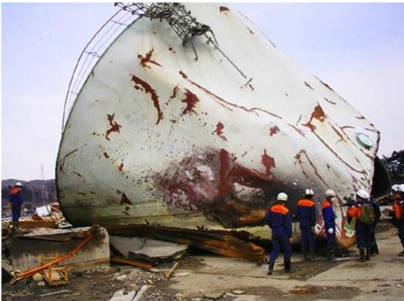
図4 津波により倒壊したタンク
