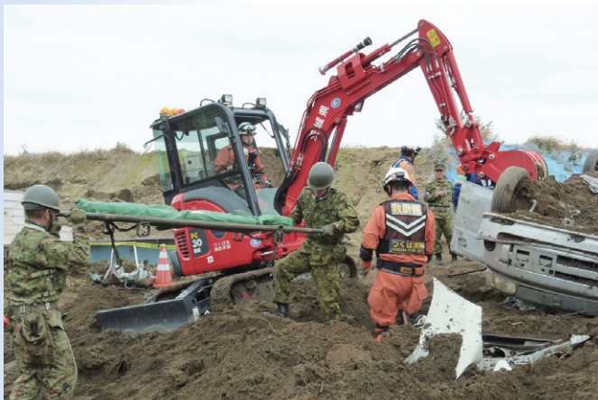
消防機関の重機を活用し、自衛隊との連携した活動状況 (養老川河川敷)
