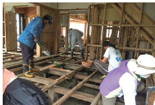
床下の泥だし (岩泉町災害ボランティアセンター提供)
