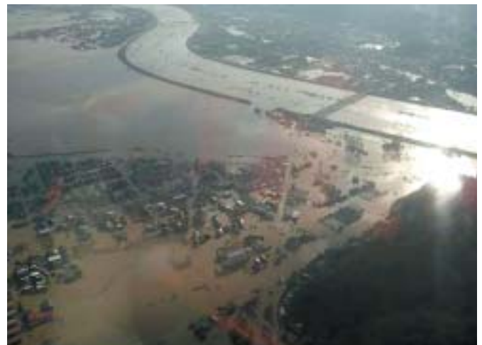
円山大橋付近の被災状況
