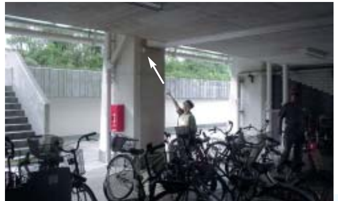
駐輪場の柱上部に設置された炎感知器
