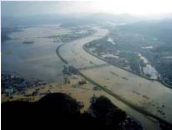
円山川堤防決壊箇所付近の被災状況
