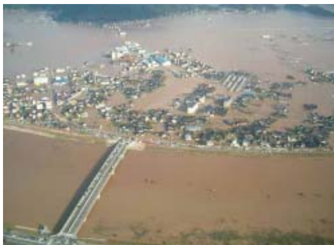
決壊箇所付近の上庄境・梶原地区の被災状況
