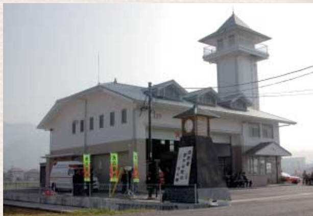
防火の願いが込められた常夜燈
