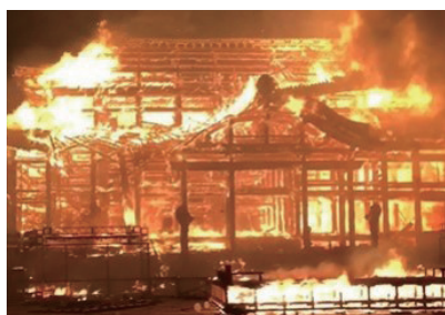
【R 1.10月 沖縄県首里城火災（那覇市消防局提供写真）】
