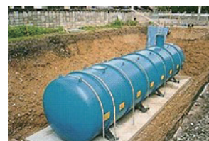
【耐震性貯水槽】
