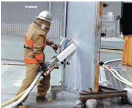
【消防防災科学技術研究推進制度の研究成果（高圧水駆動カッター）】
