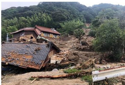
佐賀県唐津市の被害状況（唐津市より提供）
