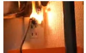
写真2 プラグからの出火イメージ(トラッキング現象)
