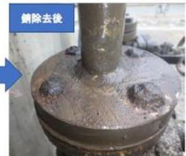
**【ステンレス鋼製フランジと炭素鋼製ボルト・ナットの組合せによる異種金属接触腐食の事例】**
