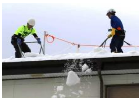
命綱、ヘルメットを装着して作業する様子（提供：新潟県）
