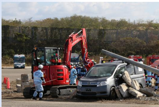
座屈倒壊建物救助救出訓練（3日）メイン会場
