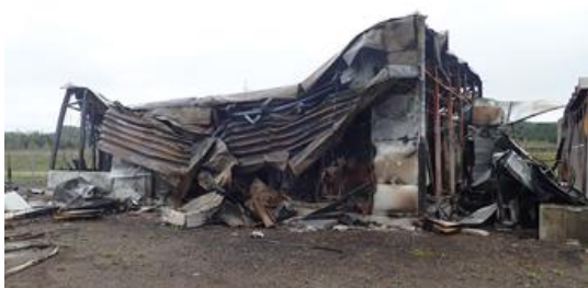
【火災後の蓄電池設備建屋】
