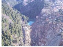
【能登半島地震における土砂ダムの例（輪島市市ノ瀬）】
