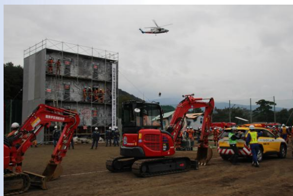
座屈倒壊建物救助訓練（天城ふるさと広場）
