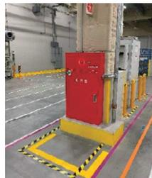
写真5 屋内消火栓設備周囲の物品放置禁止範囲の明示
