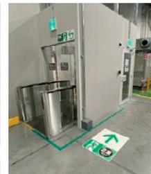
写真6 床面に避難口への誘導表示を明示
