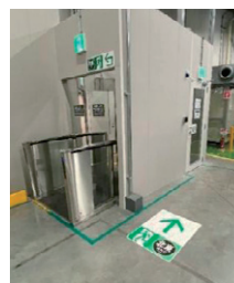
写真6 床面に避難口への誘導表示を明示
