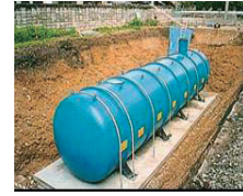
【耐震性貯水槽】
