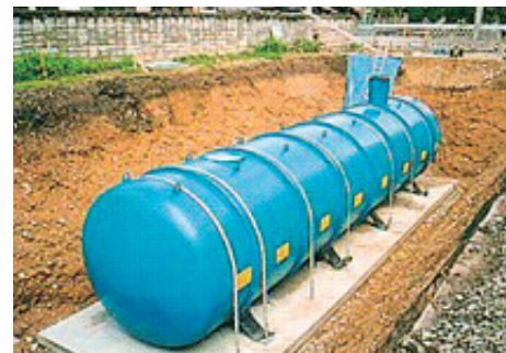
【耐震性貯水槽】
