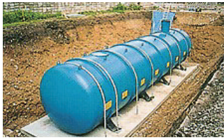
【耐震性貯水槽】
