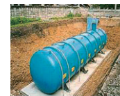
(耐震性貯水槽)
