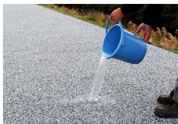
透水性の舗装
