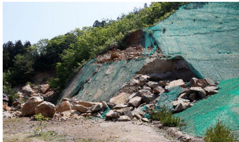
【崖崩れの様子】
