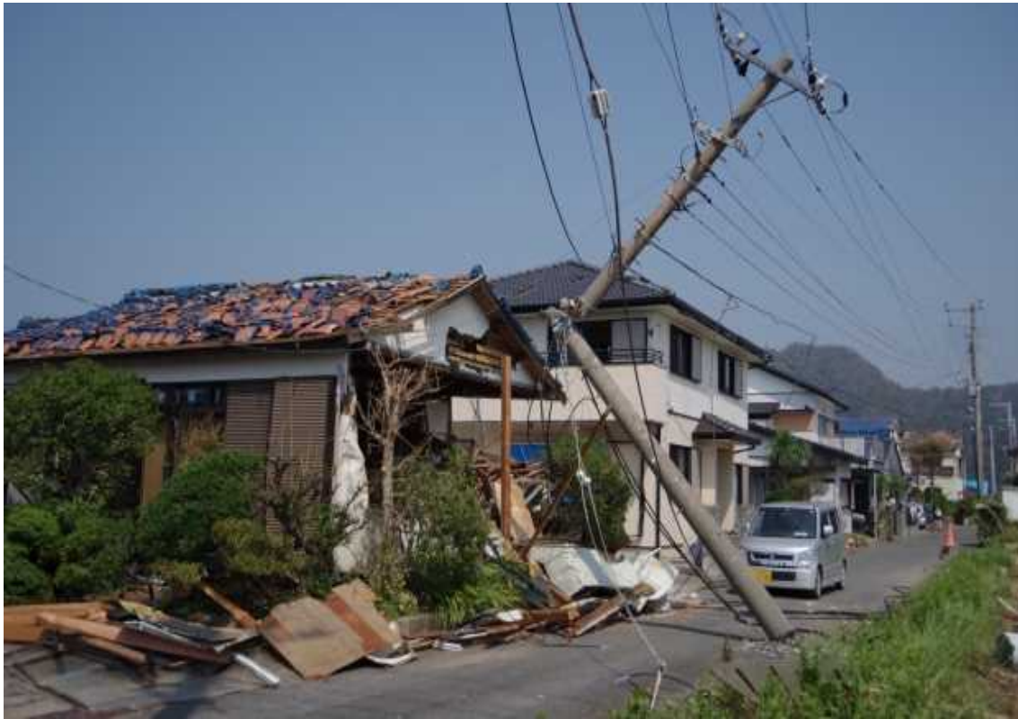
強風により折れた電柱
