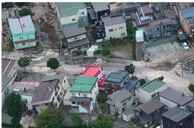
【札幌市 液状化現象の被害状況】
