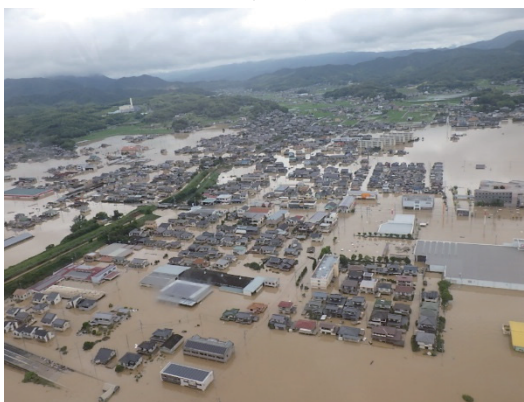
【岡山県倉敷市真備町】
