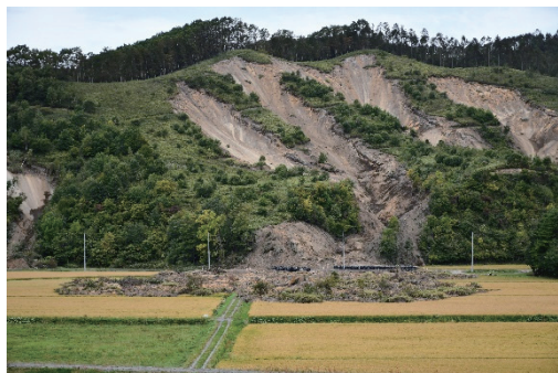
【厚真町 土砂災害の状況①】
