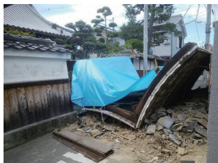
【壊れた寺の門扉】
