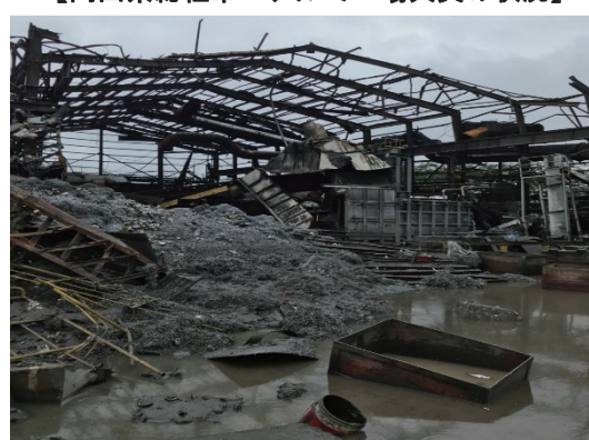
【岡山県総社市 アルミ工場火災の状況】
