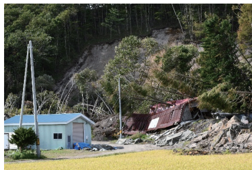
【厚真町 土砂災害の状況②】
