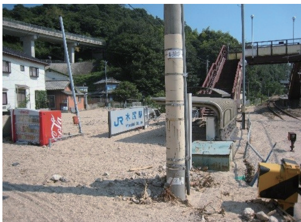
【被災した駅の様子】
