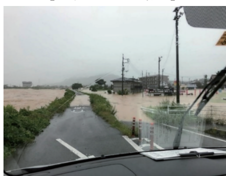
【道路が寸断した様子】
