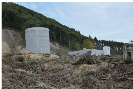
【厚真町 土砂災害の状況③】
