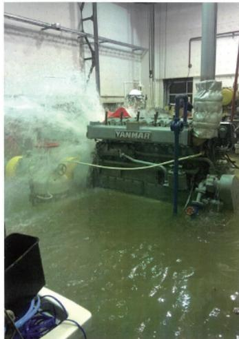
7月6日14時30分からエンジンポンプ3台、電動水中ポンプ9台全てを稼働させ排水を行っていましたが、配電盤への水の侵入により20時15分に電動水中ポンプ9台、エンジンの浸水により20時30分にエンジンポンプ3台の稼働を停止せざるを得なくなりました
