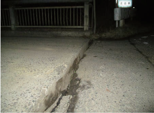
白木沢跨道橋（村田町役場提供）
