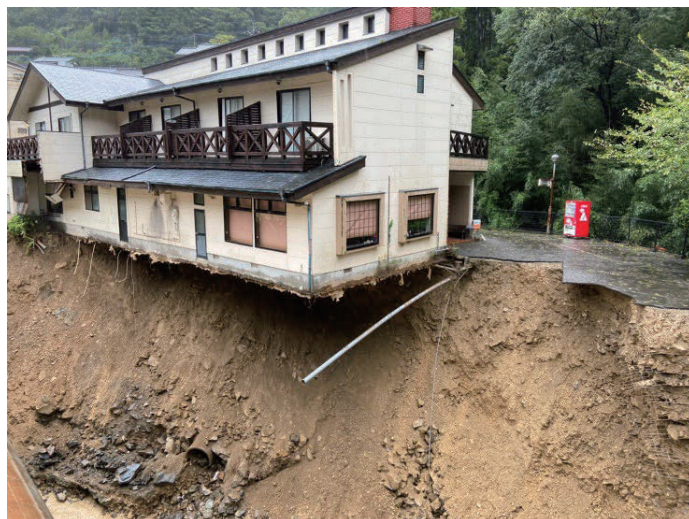
土砂が流出し全壊の民宿（椎葉村提供）
