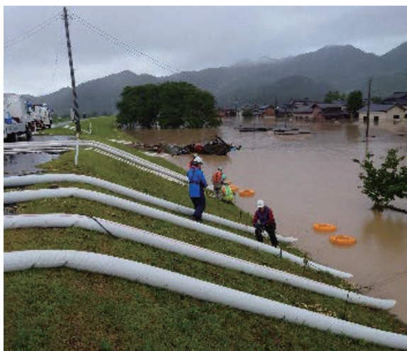
羽越河川国道事務所による排水処理状況（高田排水樋管付近：8月4日）（関川村提供）
