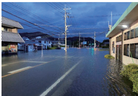
祝子川・富美山地区の浸水被害
