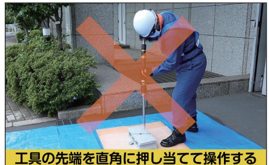
工具の先端を直角に押し当てて操作する
