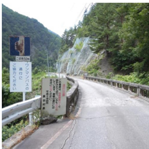
土砂崩れが起こりそうな場所
