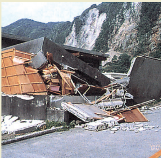
火山性の地震により倒壊した家屋(平成12年6月 新島村)
