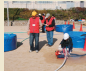
仮設水槽、ポンプなどを準備
