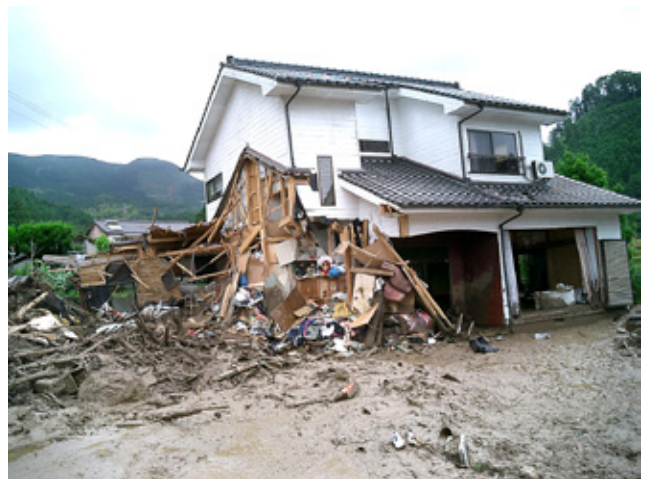
土砂で壊れた家
