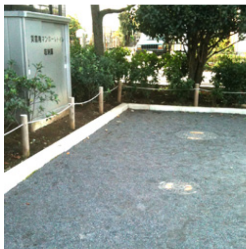
災害用マンホールトイレ
