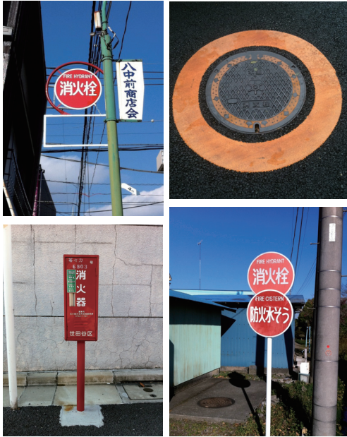
左上：消火栓標示板 右上：消火栓、左下：街頭消火器 右下：防火水そう（消火栓）標示板と 防火水槽（標示板の左後方）
