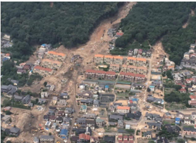
平成26年8月の広島市土砂被害の状況 (提供：内閣府)
