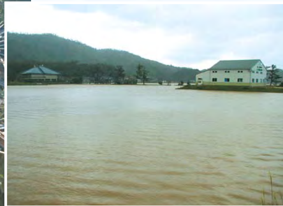
竹野川のはん濫で浸水した田畑(京丹後市丹後町)
