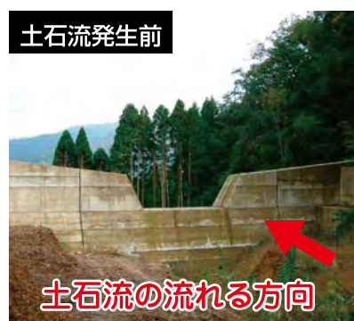
砂防えん堤の上流側の様子
