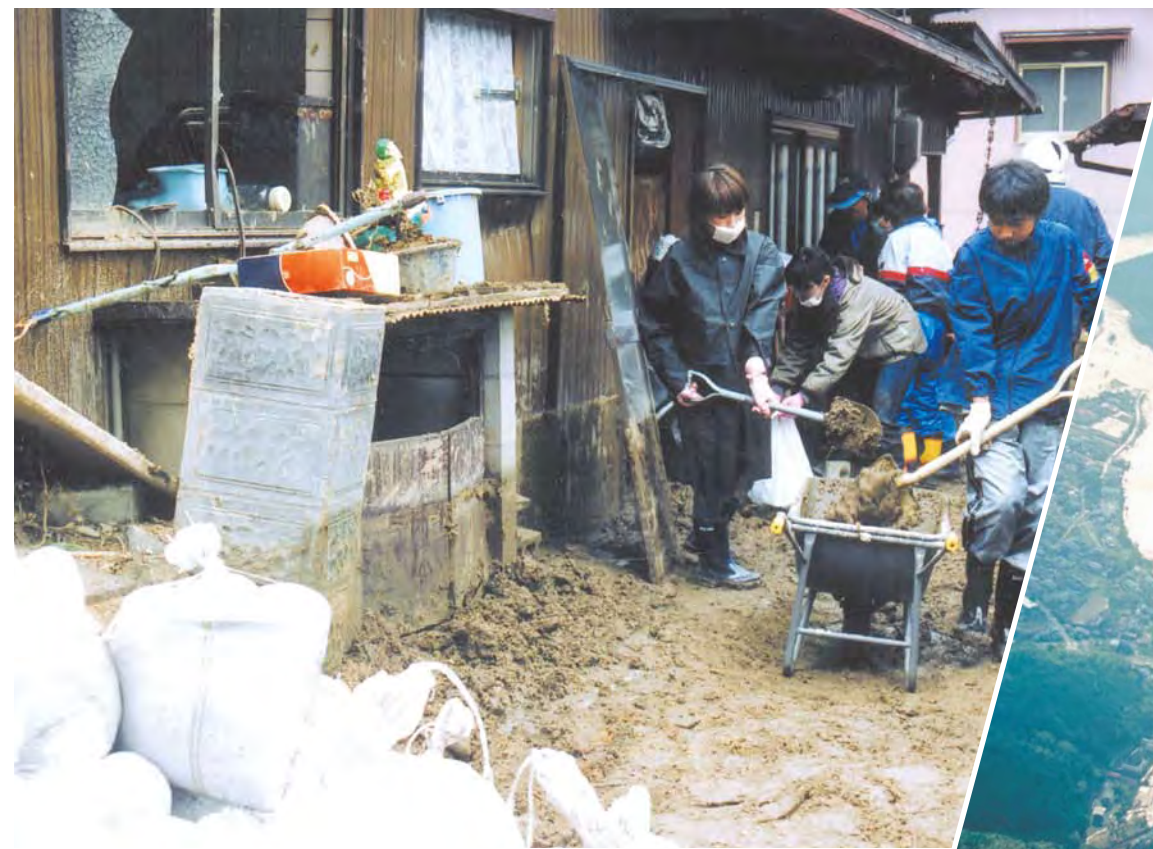
みんなで力を合わせた復旧作業(宮津市)
