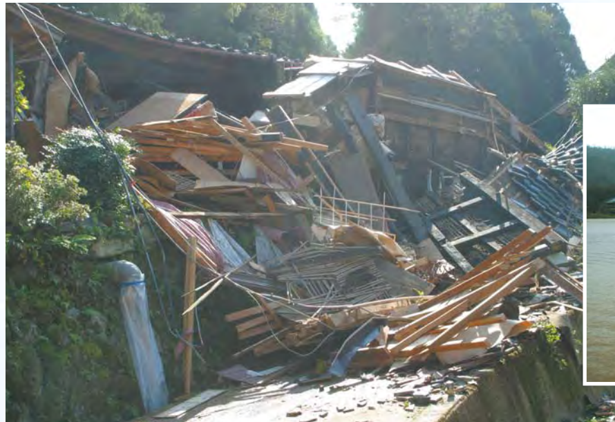
がけ崩れで全壊した家屋(京丹後市弥栄町)
