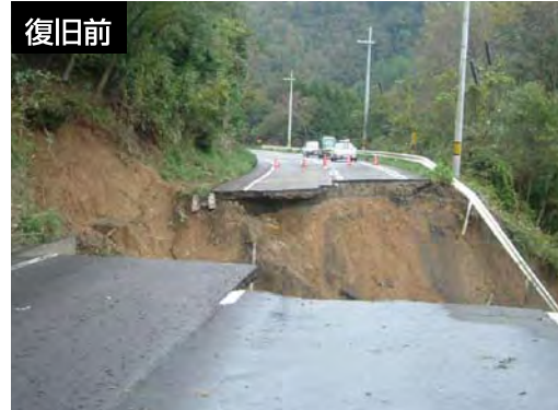
崩壊した国道173号(綾部市)
