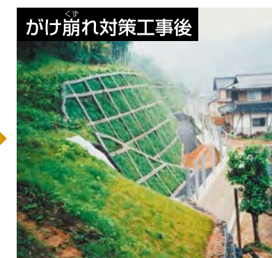
工事によって安定したがけ
