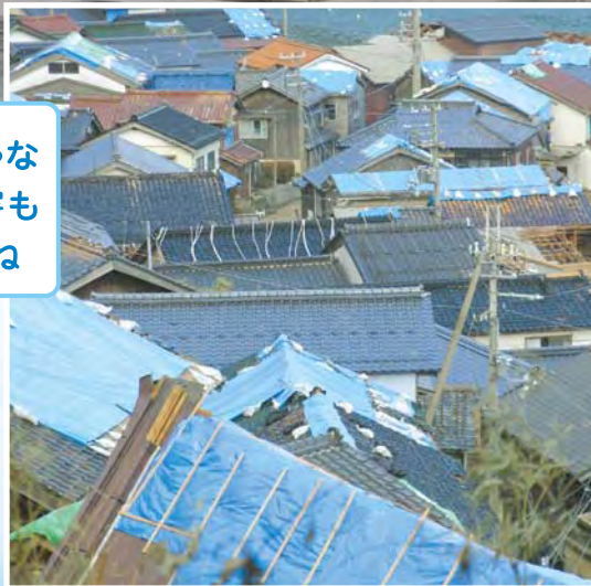
屋根が吹き飛び、雨風を防ぐために、ブルーシートで応急対応する住宅(伊根町蒲入)
