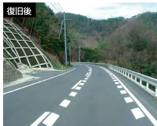
復旧工事完了
