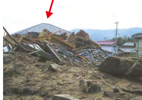
土石流によって全壊した家屋
