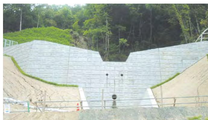
次の土石流をくい止めるため新しく作られた砂防えん堤
