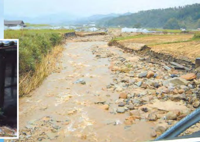
堤防が壊れた野田川では、約75haが浸水
