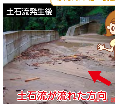
砂防えん堤にたまった土砂
