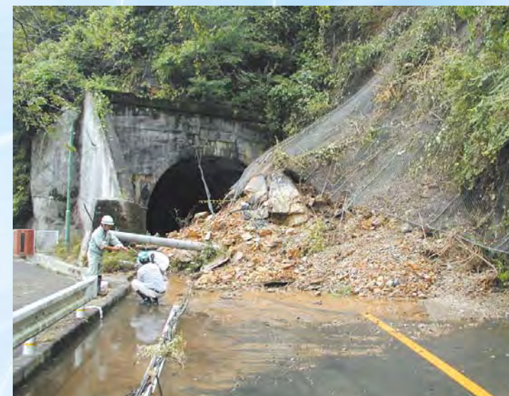
かけ崩れで通行できなくなった府道綾部宮島線(旧美山町)
