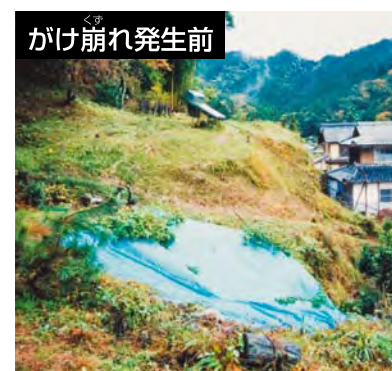
大雨によって崩れそうながけ
