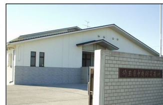
埼玉県中央防災基地
