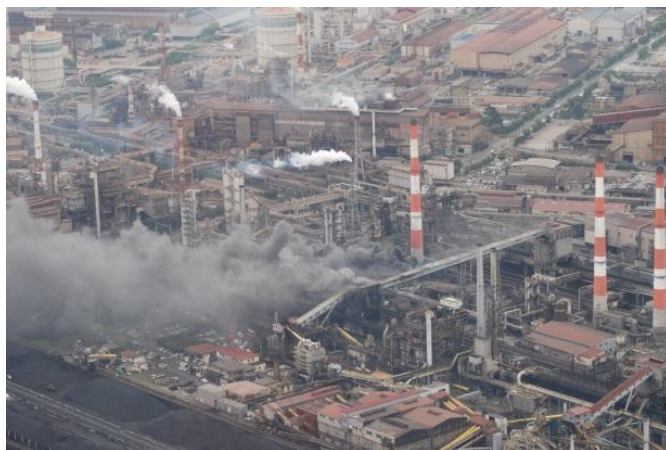
火災現場全景
