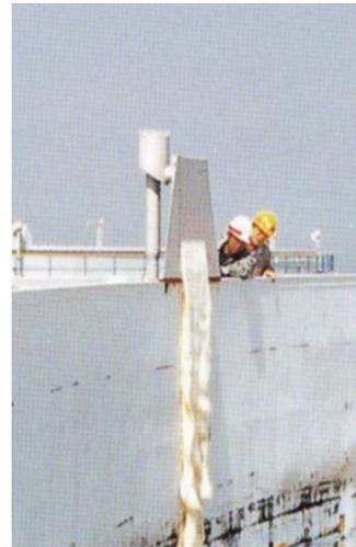
写真2 特型泡放出口からの泡放射状況
