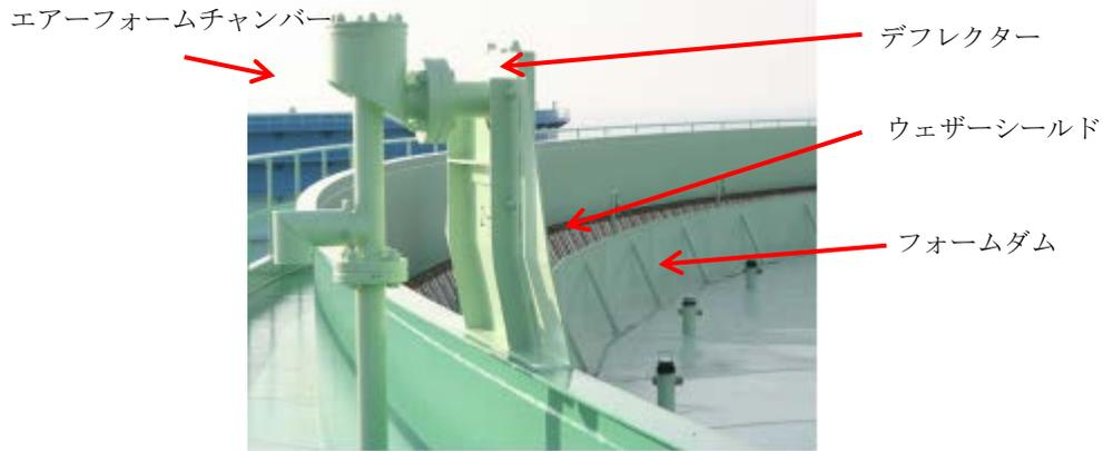
写真1 特型泡放出口の設置状況
